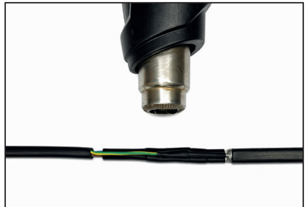
3.9. З'єднати дроти заземлення, поверх них надягнути термозбіжну трубку довжиною 70 мм та усадити її.
